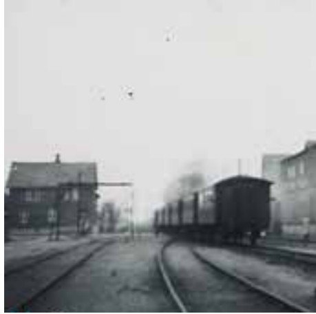
Malling Station i røg og damp, 1956
